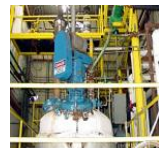
パイロットスケール
