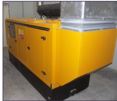
緊急時発電装置
