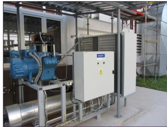
冷却プラント
