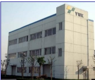
パイロットプラント
