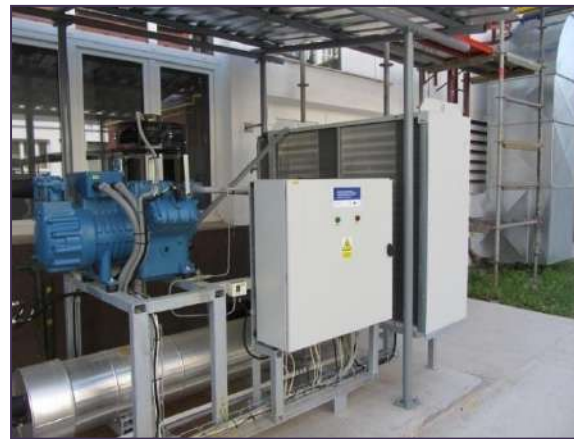
冷却プラント
