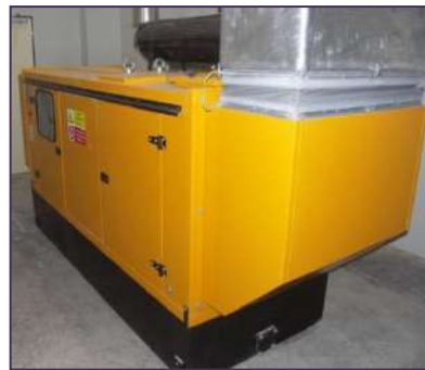
緊急時発電装置
